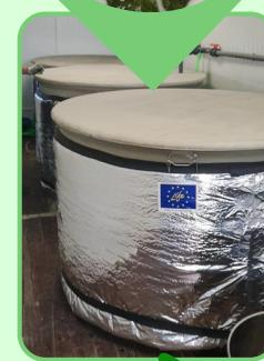
En la segunda etapa, este inóculo es introducido en los tanques cerrados con el agua residual durante 3 días. En este tiempo de residencia los tanques permanecen aireados, agitados y calentados a 25-30°C para conseguir un efluente que cumpla los parámetros legales de vertido y el óptimo crecimiento de las algas.
